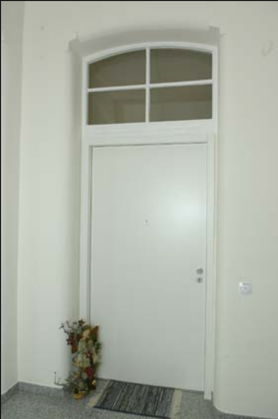
Harmonische Verbindung von Alt und Neu: alte Fenster - neue Brandschutztür
