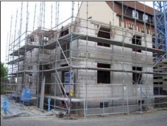
Der rechte Seitenflügel wurde im Krieg zerstört...
