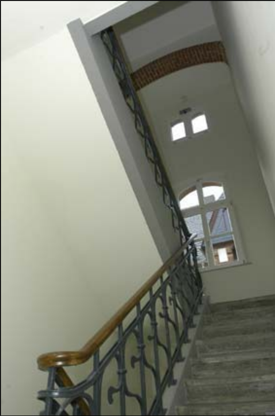
...Treppe aus Naturstein und Geländer sind im Original erhalten
