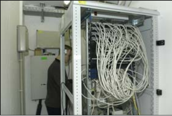
Hochmodern: die Verteileranlage für Telefon, Internet und Fernsehen
