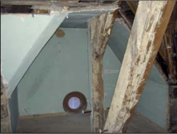
...Gebälk wurden freigelegt
