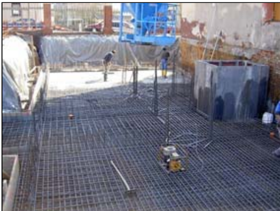
Baubeginn war am 8. März 2004
