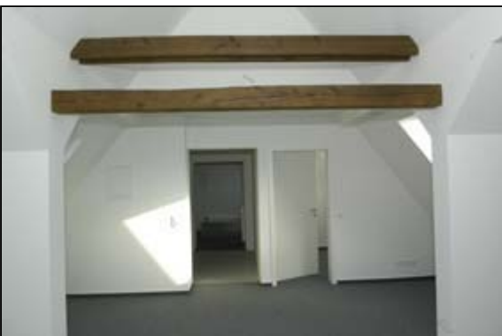
...über 100 Jahre alte Balken
